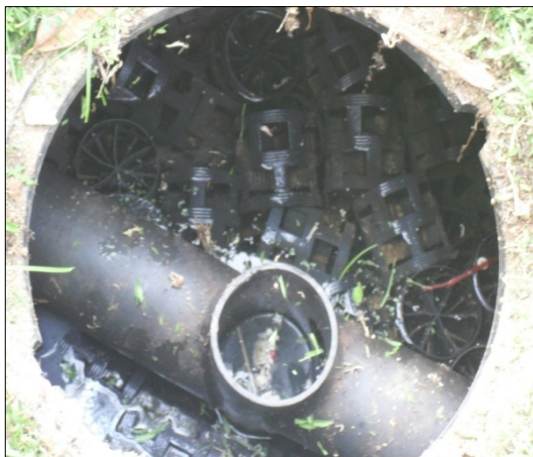
1.ระบบบ่อเกราะและบ่อกรองไร้อากาศ (SAF)
